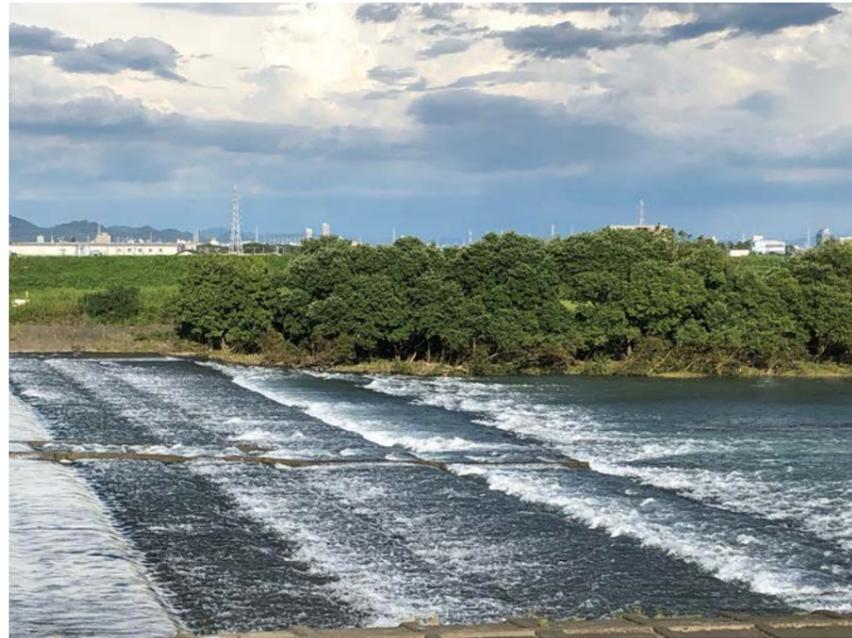
水量が豊富だと全断面魚道として、少ないと中央と岸近くの魚道が機能する、自然石を利用した落差工の写真は、生き生きとした水流が樹林や堤防の草色、空の青色を背景に、落差工が河床安定や生息場の確保、周囲景観との調和に役立っていることを表しています。
