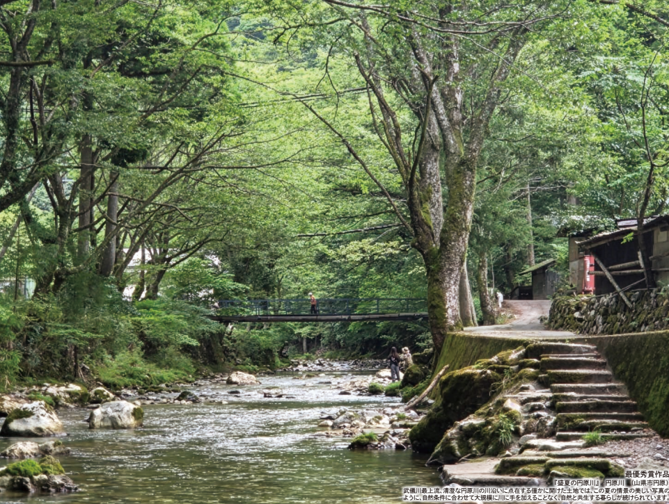
『谷あいの共生』 養老公園 ◎（養老郡養老町養老） 養老山系の山あいから扇状地群に至る一帯の成功例が多数見られる治山・砂防工事の一つで、名勝養老の滝から流れ下る急流を制御する自然石の落差工と流路工が緑溢れる周辺の自然環境に溶け込んでいます。
